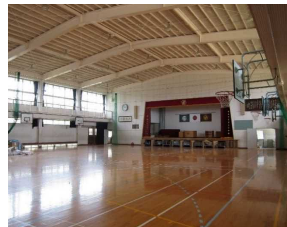
<吊り天井を撤去した体育館>
