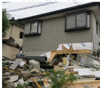
<隣棟建物の衝突>
