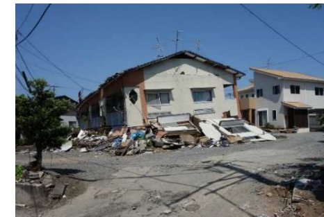
<S造：旧耐震建築物>
