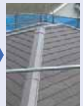
軽い屋根材への葺き替え
