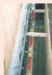
無筋コンクリートへの増し打ち補強、耐力壁を新設する部分の基礎の新設等
